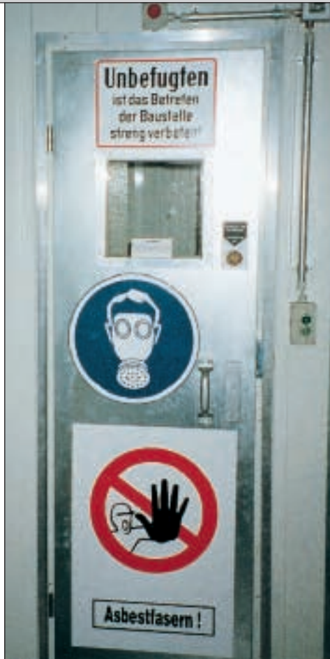
Mehrkammerpersonenschleuse. Die Kammern wurden versetzt angeordnet.
