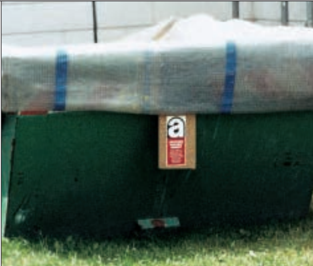
Mit Plane abgedeckter Baustellencontainer
