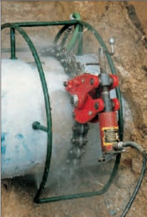
Trennen eines AZ-Rohres mittels Kettenroherschneider (BT 3)
