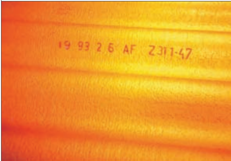
Kennzeichnung einer asbestfreien Faserzementwellplatte mit Herstellungsdatum und Zulassungsnummer: Woche (19), Jahr (93), Werk (26), asbestfrei (AF), Zulassung (Z31.1-47)
