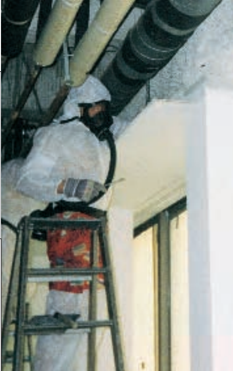
Abnehmen der Zwischendeckenplatten im Randbereich
